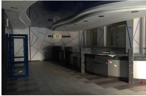
Фотография 3.5. Внутреннее состояние помещений
