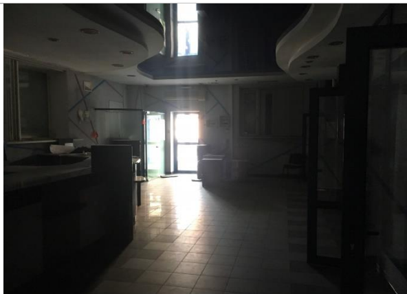
Фотография 22. Внутреннее состояние помещений
