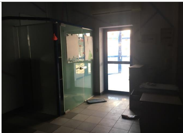
Фотография 24. Внутреннее состояние помещений
