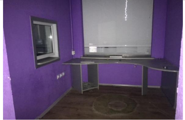
Фотография 3.6. Внутреннее состояние помещений
