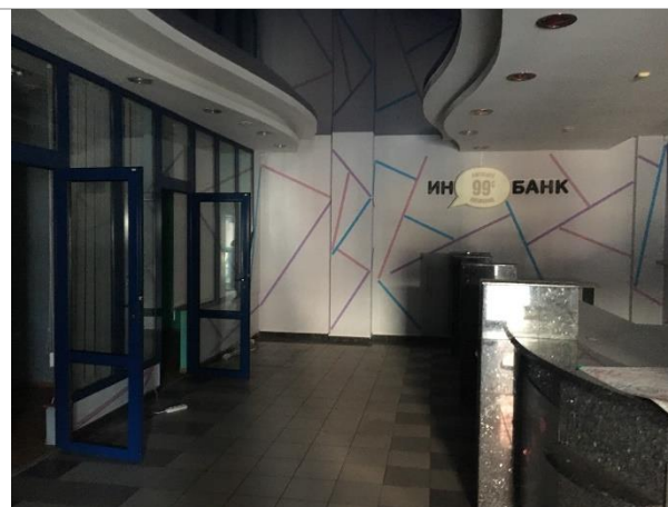
Фотография 20. Внутреннее состояние помещений
